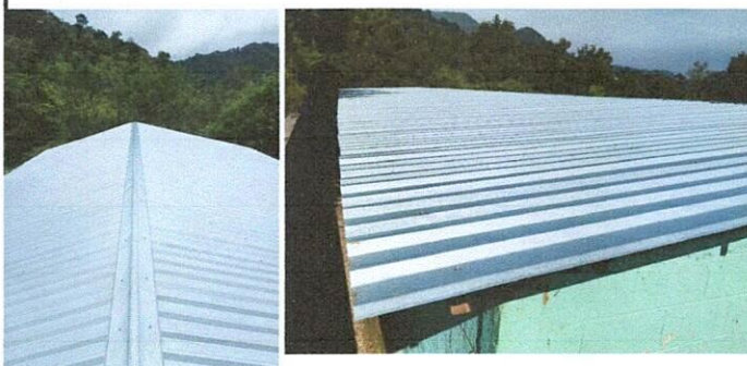
Foto 1: Cubierta de Lámina de 2 aulas, y pintado de costanera.
